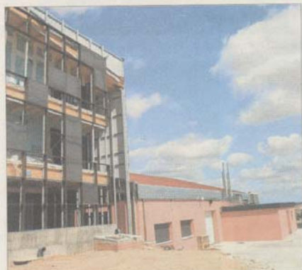
Obras para la construcción del centro de enoturismo.
